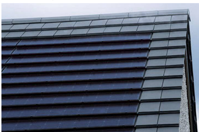
Esempi di pannelli fotovoltaici integrati in coperture di colore grigio
