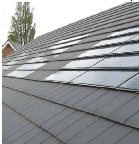
Esempi di pannelli fotovoltaici integrati in coperture di colore grigio
